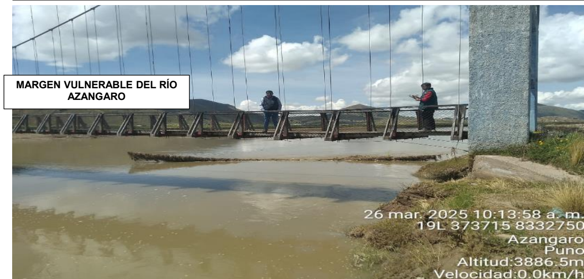
FIGURA N°03: COLUMNAS DEL PUENTE COLGANTE CAMPUCO EXPUESTOS A LA SOCAVACION ANTE LA CRECIDA DEL RIO AZANGARO DEL DISTRITO DE SANTIAGO DE PUPUJA, PROVINCIA DE AZANGARO - PUNO
