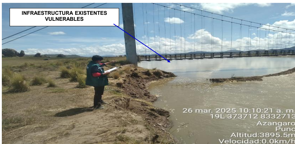
FIGURA N°02: PUENTE COLGANTE CAMPUCO VULNERABLE A LA SOCAVACION ANTE LA CRECIDA DEL RIO AZANGARO DEL DISTRITO DE SANTIAGO DE PUPUJA, PROVINCIA DE AZANGARO - PUNO
